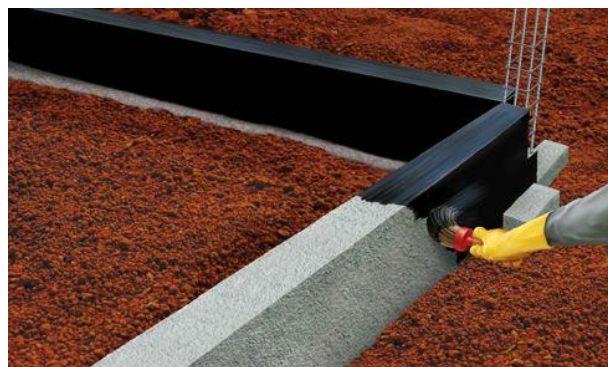
Figura 9: Aplicação deverá ser feita; - Sobre viga, laterais internas e externas, preferencialmente com recobrimento total da viga em uma demão, e após termino de secagem reaplicar em pontos que eventualmente se mostrem não cobertos.
